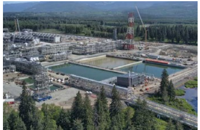
LNG Canada construction, B.C. (WC Files).
